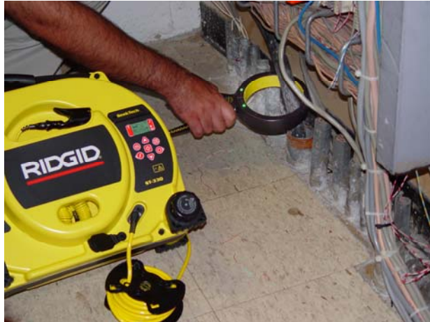
Рис. 16: Индукционный зажим присоединен к кабелю
